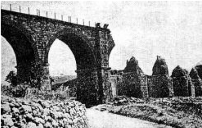
Isernia. Ponte Santo Spirito ridotto a rudere
