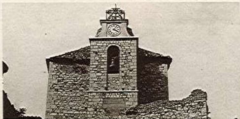
La Chiesa: prima del restauro
